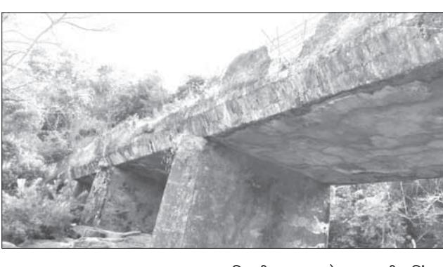
पूल नव्याने उभारण्याची गरज या पुलाच्या प्लास्टरमधून लोखंडी सव्या बाहेर पडल्या आहेत तर काही खाली कोसल्यादेखील आहेत. पुलाची सरक्षक कठडे तुले आहेत. अनेक ठिकाणी प्लास्टर निघाले आहे. सर्वत्र गवताचे आच्छादन आहे. त्यामुळे पूल नव्याने उभारण्याची गरज आहे.
